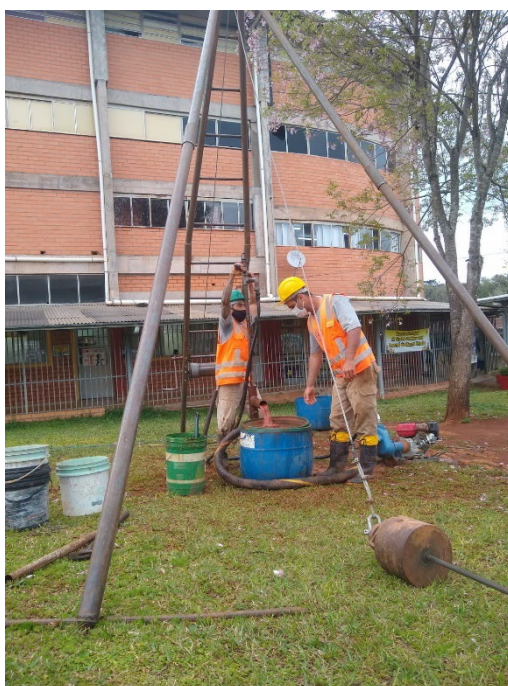
Foto 8. Lavação por trepanação com circulação de água.
