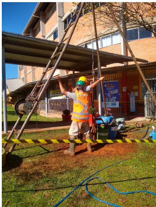
Foto 13. Lavação por trepanação com circulação de água.
