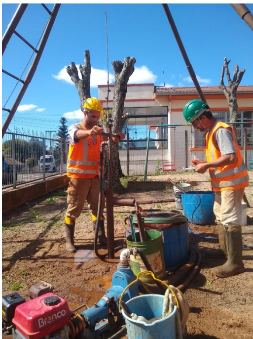
Foto 3. Lavação por trepanação com circulação de água.
