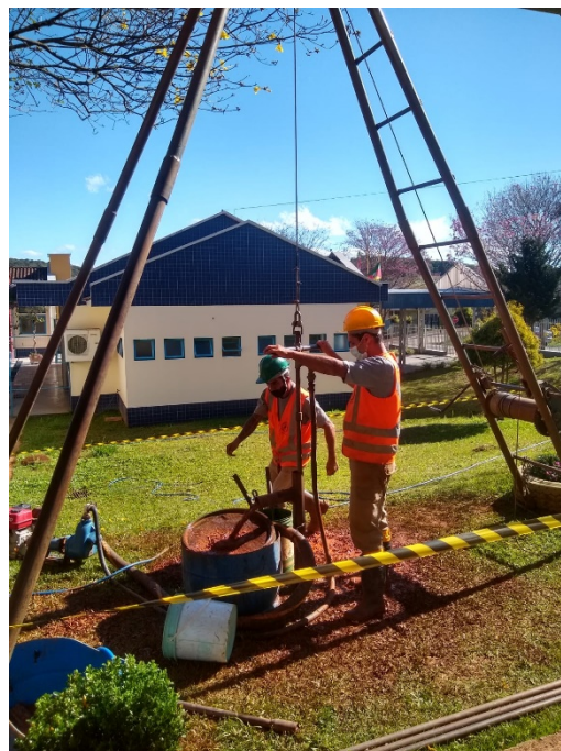
Foto 14. Lavação por trepanação com circulação de água.
